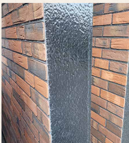
Zijaanzicht gevelplaat inclusief isolatielaag
