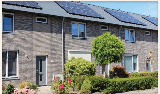
Zonnepanelen, warmtepompen en geïsoleerde voorzetgevels aan de Dahliastreet
