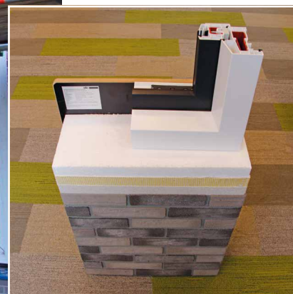
Onder: Steenstrip geplakt op een dikke laag isolatieschuim met daarop het kunststof kozijn
