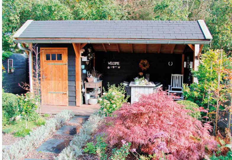
Voor een tuinhuis, overkapping en aanbouw is een omgevingsvergunning nodig
