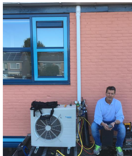
Installatie buitenunit hybride warmtepomp
