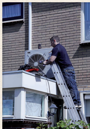
Plaatsing van buitenunit warmtepomp
