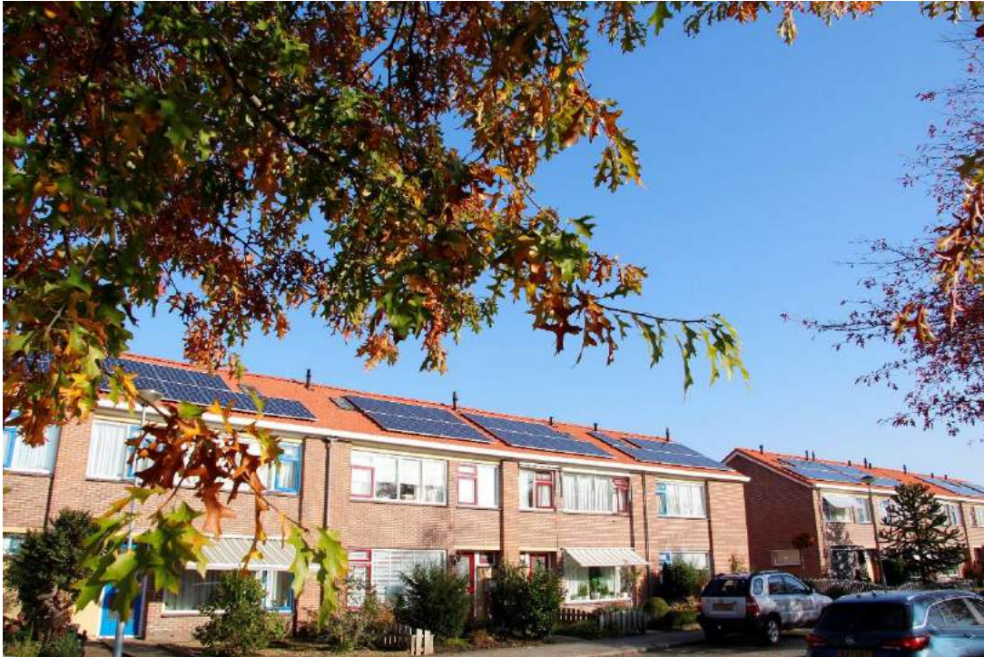
Dakrenovatie en zonnepanelen, Wilhelminalaan Hoogkarspel
