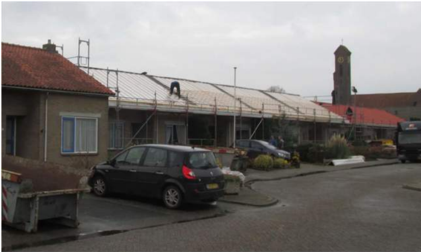
Dakrenovatie, Sportlaan te Onderdijk
