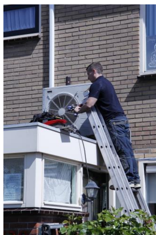
De buitenunit kan zowel op daken of aan gevels bevestigd worden
