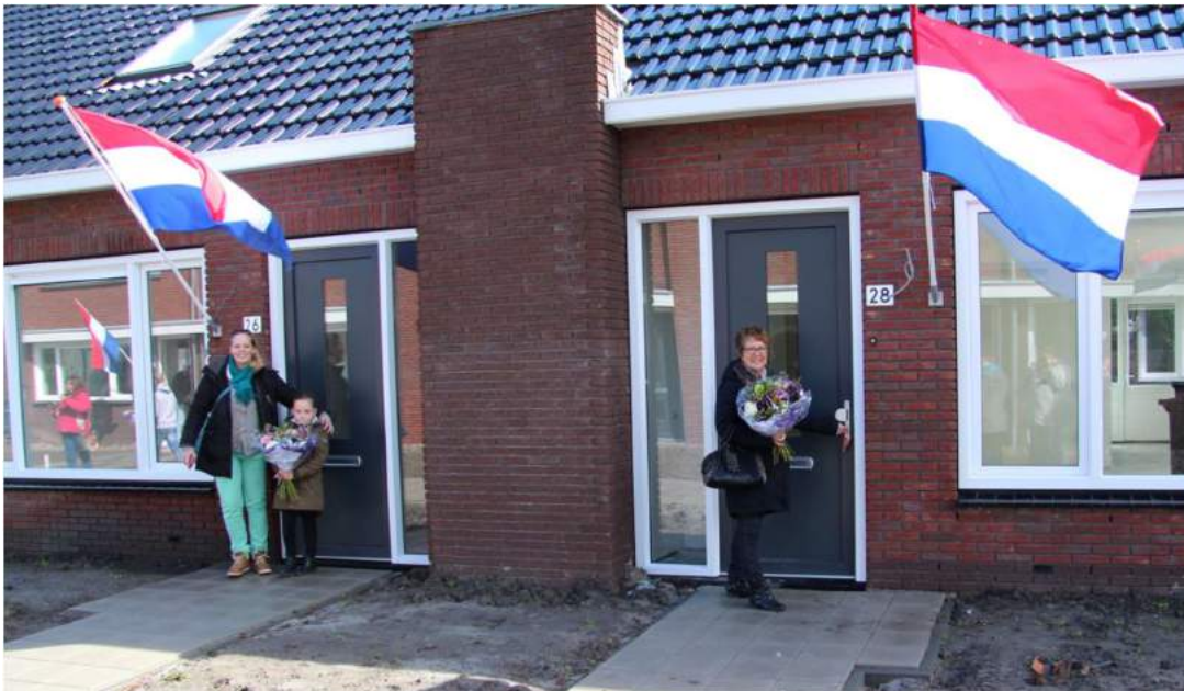
Foto, oplevering nieuwbouw P. Kistemakerstraat, Andijk
