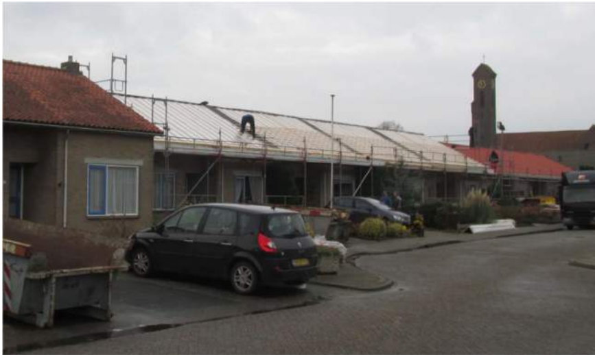
Dakrenovatie, Sportlaan te Onderdijk
