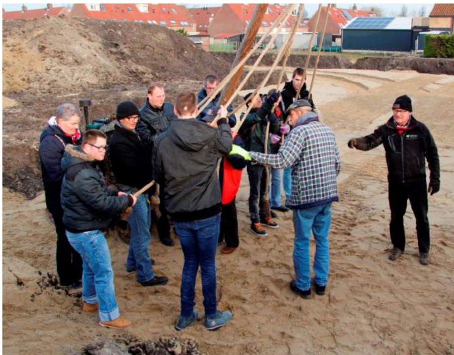
Een deel van de bewoners slaat de eerste paal
